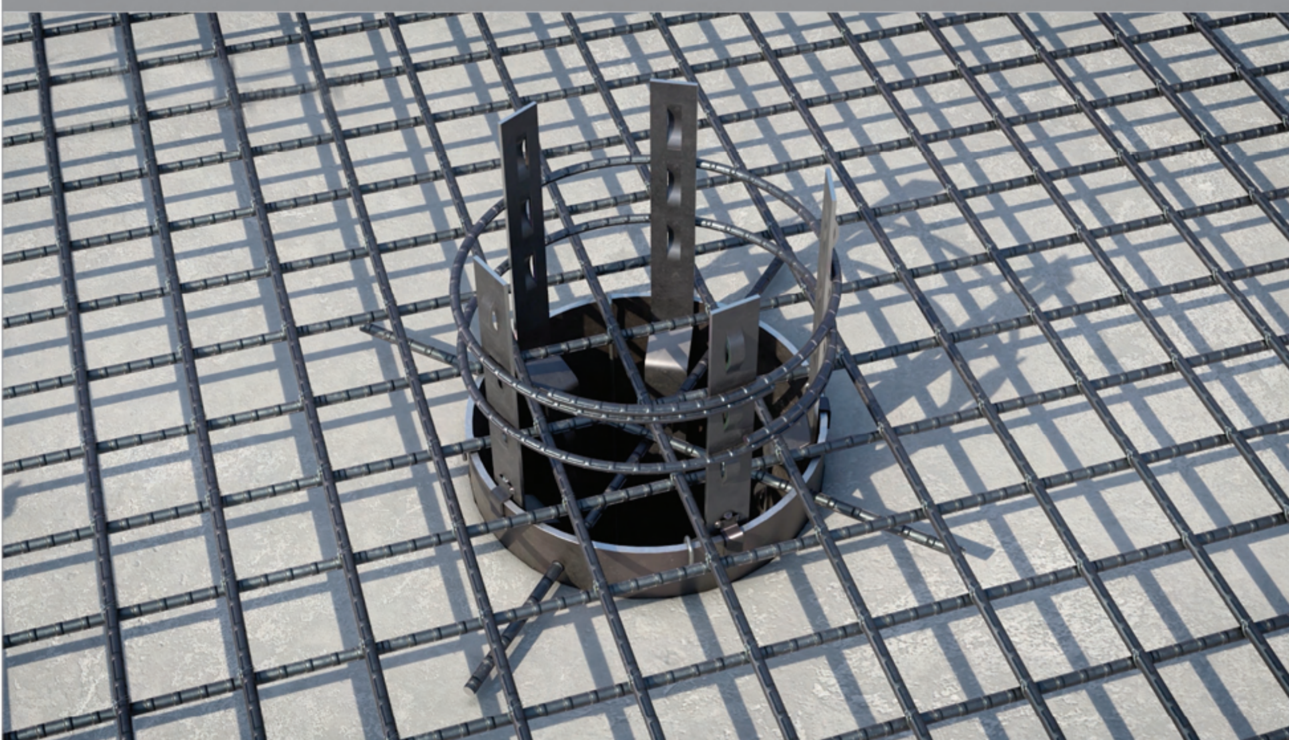
STEP 7 _ 고정링 철근 조립
