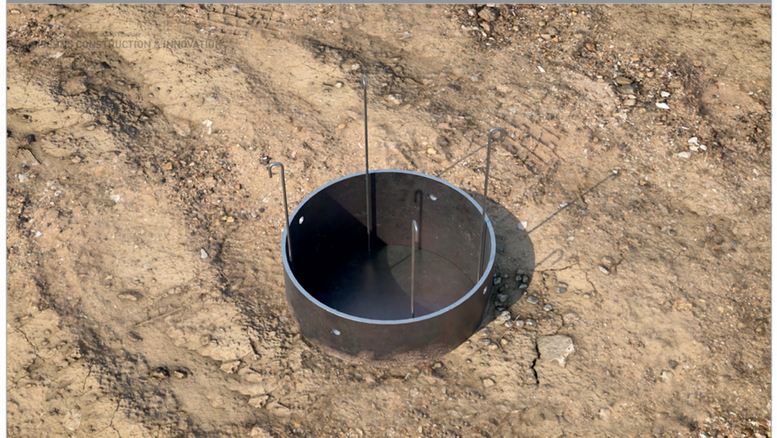
STEP 4 _ 하부거푸집 설치
