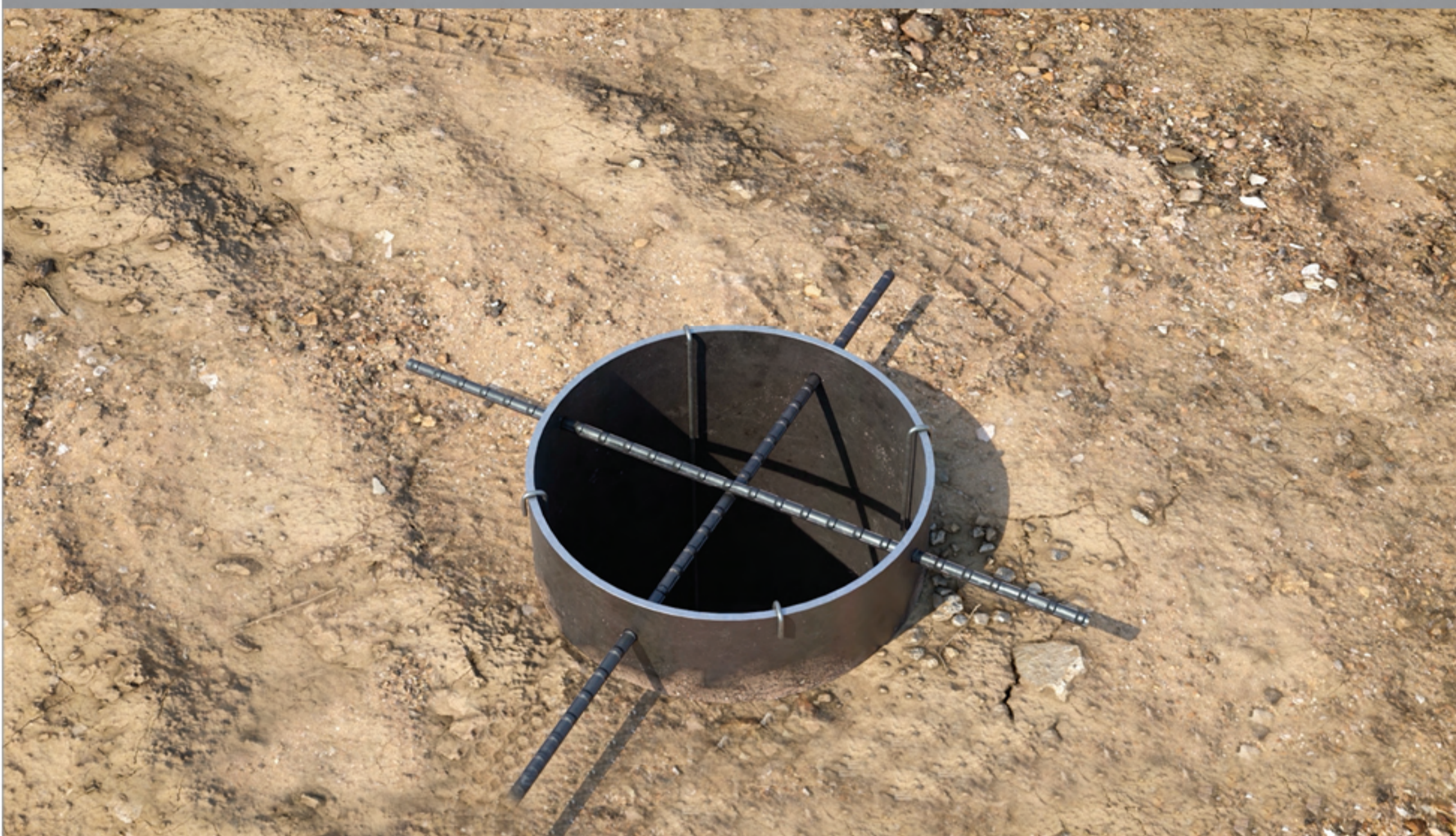
STEP 5 _ 관통철근 설치
